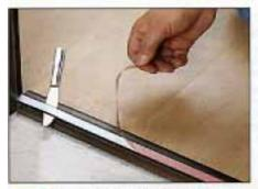
Jetzt legen Sie den om Türblutt zu befestigenden Mognetstreifen auf die Mognetleiste und ziehen die Schutzfolie ab.
