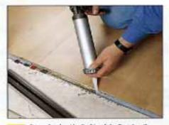
5 Bevar Sie das Alu-Profil auf die Türschweile schrauben, sollten Sie die gesamte Montagefläche soegfältig mit Sillison ausspritzen:
