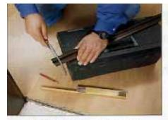
Die naue Dichtschiene wird eusgamessan und mit der Pucksäge abgelängt. Anschließend die Sögekanten mit der Feile glätten.
