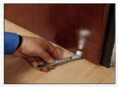
1 1 Bei geschlossener Tür können Sie den selbstklebenden Magnetstreifen mit dem vorher eingelegten Messer unten ens Türblicht drücken.
