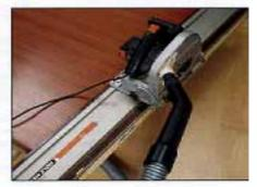
Die Tür wird ausgehängt und mit Hilfe der Handkreissäge und einer Führungsschiene entlang der Markierung obgeschnitten.
