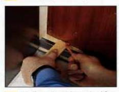
Mit Hille eines 6 mm dicken Brettchens leßt sich nun die Unterkente des Türblattes parallel zur montlierten Bodenleiste anneißen.
